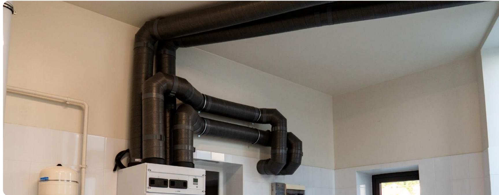
Воздуховоды имеют антистатические и антибактериальные свойства (специальный состав на поверхности воздуховода не дает возможности прилипнуть пыли и засорить воздуховод, бактерии, попавшие на поверхность воздуховода, погибают через 72 часа).
